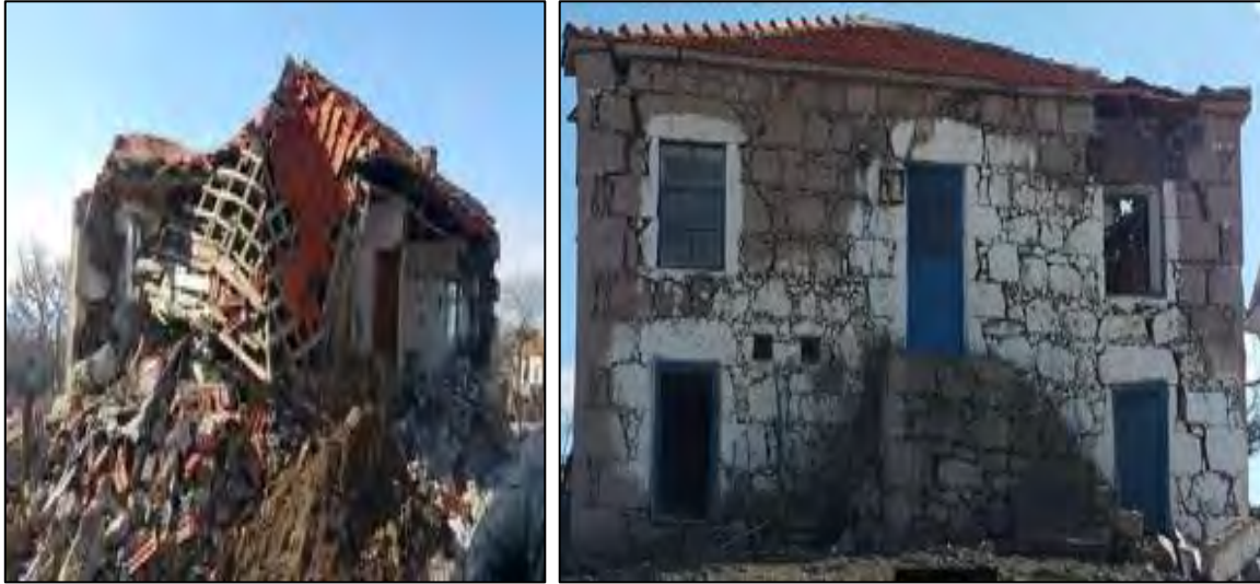
Şekil 1b. Deprem Sonrası Hasar Almış Yığma Yapılar (Livaoğlu, vd., 2017)
