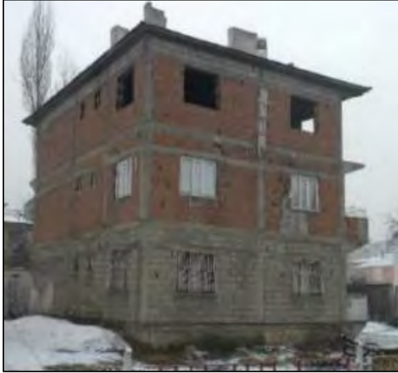
Şekil 2c. Kuşatılmış Yığma Yapı (Smyrou 2016)
